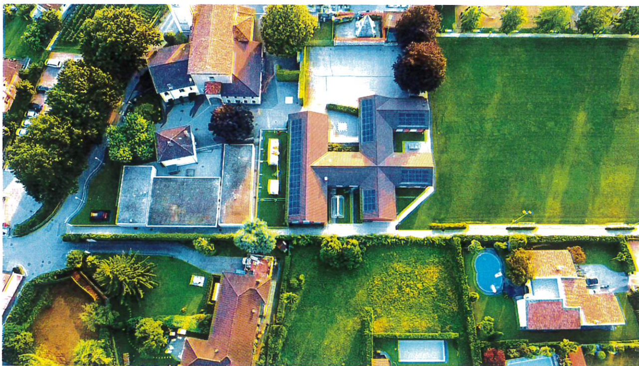
foto aerea della zona di intervento
