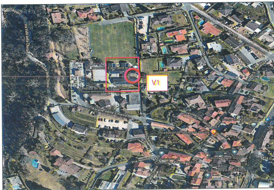
Immagine 1: Immagine satellitare delle scuole elementari, riconoscibile all'interno del rettangolo rosso. Nel tondo (in rosso) sono deducibili gli spazi interessati dall'intervento (V1), integrati nel presente rapporto.
